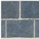
石貼り2（車庫下地 み・材工）
