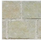
石貼り1（車庫下地 み・材工）
