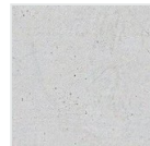
車庫土間コンクリート (材工)
